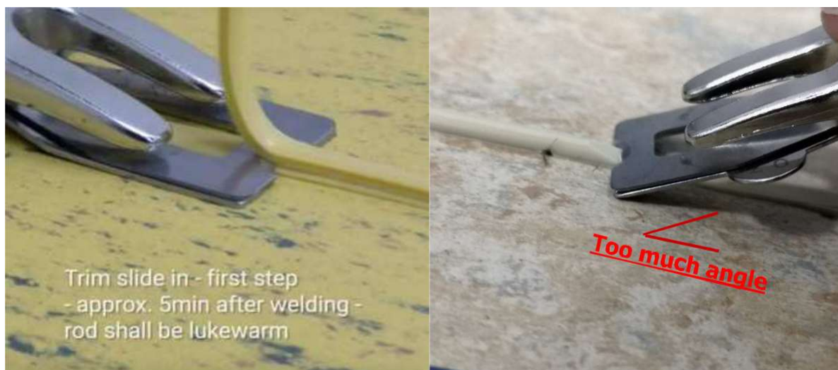
Pilt 2 [ Tekst piltide: Trimmige liuguriga – esimene samm – umbes 5 min pärast keevitamist – keevis leige; Liiga suur nurk]
